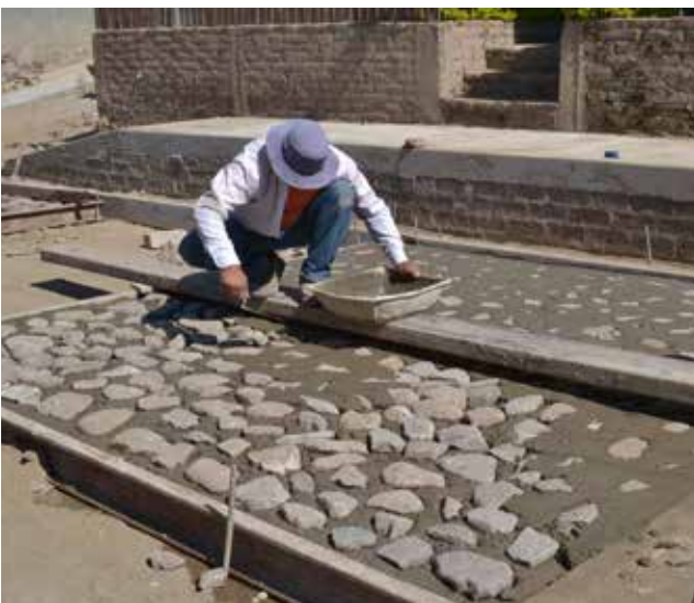
Construcción de piedra ahogada en concreto, machuelos y banquetas y red hidrosanitaria en la calle Ramón Corona de la delegación de Usmajac con una inversión de $1,170,150.39
