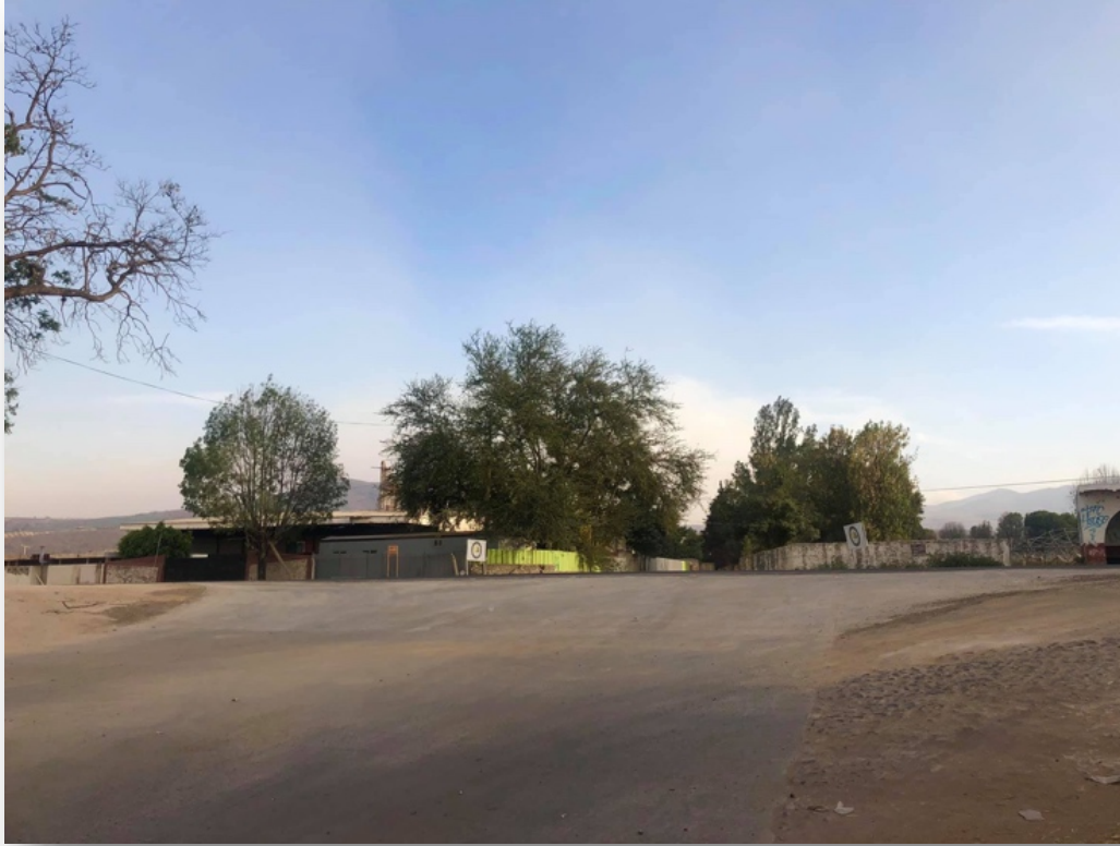
Construcción en concreto hidráulico de la rampa de acceso a la Delegación de Usmajac, municipio de Sayula, Jalisco. Con un costo de inversión de $ 335,095.26
