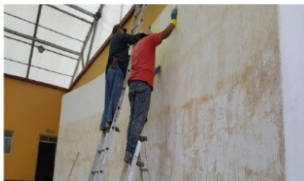
MANTENIMIENTO, PREPARACIÓN DE MURO EN CASA DE LA CULTURA
