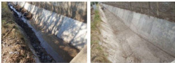
MANTENIMIENTO DESAZOLVE DE CANAL LOS TRES GARCÍA
