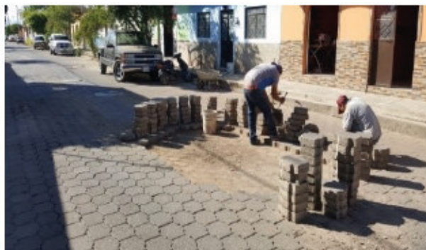
MANTENIMIENTO, REPARACIÓN DE BACHES EN CALLE CONSTITUCIÓN
