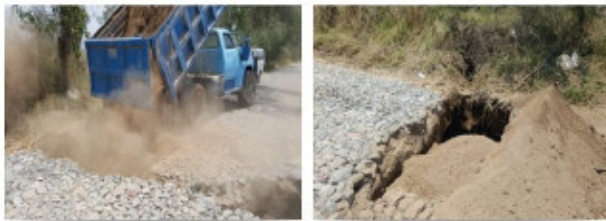
MANTENIMIENTO, REPARACIÓN DE EMPEDRADO EN CALLE REVOLUCIÓN MEXICANA
